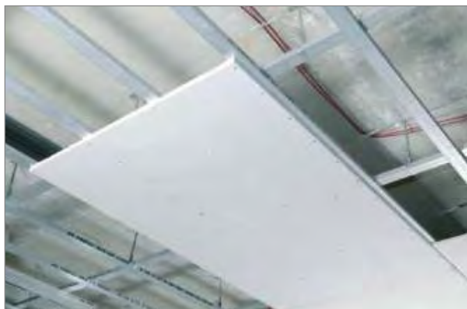
Imag. 8-5 elemente de tavan montate
