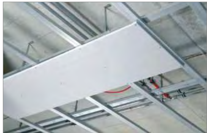
Abb. 9-5 Montarea elementelor de perete la tavan
